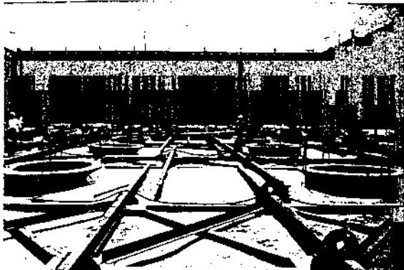
Fig. 19 - Particolare della platea di fondazione gettata in subacqueo : si notino le estremità superiori dei tralicci emergenti dal getto.
