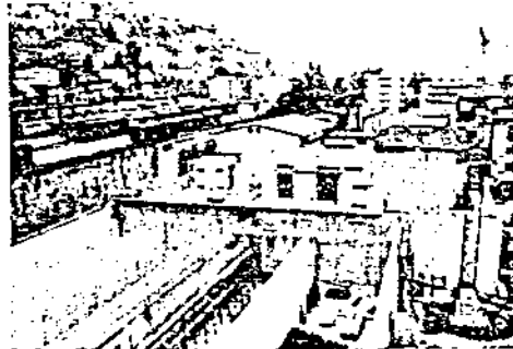
Figura 39. Primo piano: bacini di aerazione Secondo piano: bacini di equalizzazione
