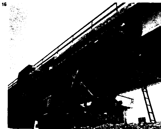
14 - Degradazioni localizzate del viadotto; 15 - Riparazione effettuata con malta espansiva reoplastica; 16 - Applicazione della vernice cementizia impermeabilizzante; 17-18 - Visione del viadotto protetto con la vernice cementizia.
