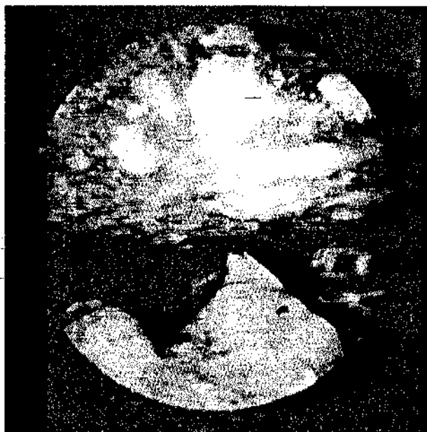
Fig. 3 - Fotografia scattata con l'endoscopio della ripresa di getto allineamento (in basso)/serraggio (in alto) in una zona con gravi dissesti
