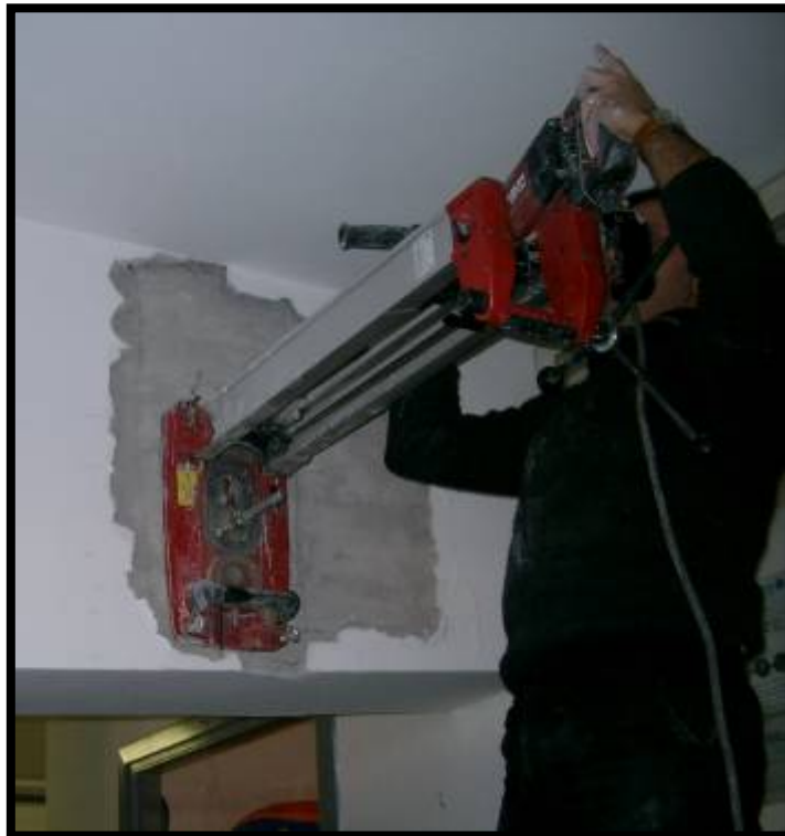
Carotaggio su elementi in c.a.
