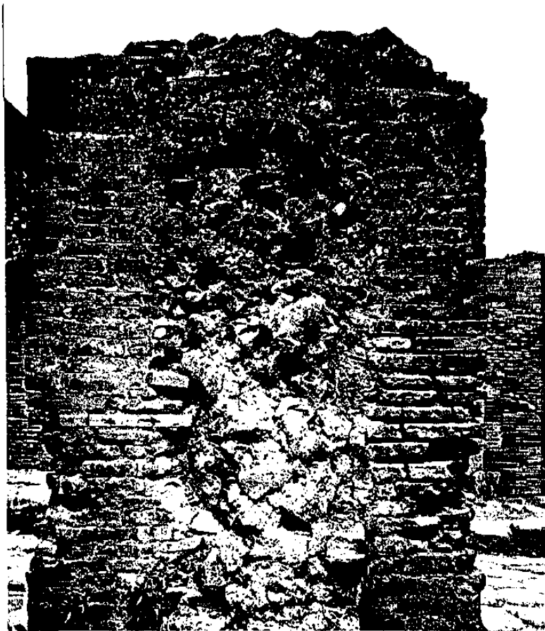
Fig. 1 - Esempio di opus caementicium (Pompei - Terme del foro)
