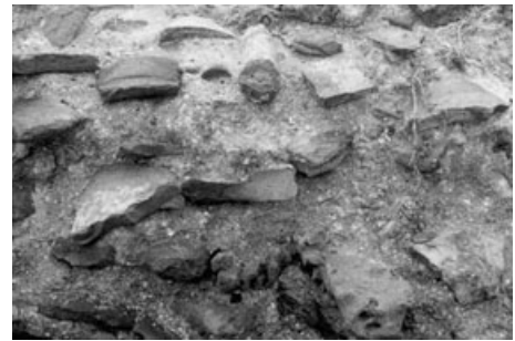
Figura 4 - Calcestruzzo romano con rottami di anfore impiegato per il molo di Cosa
