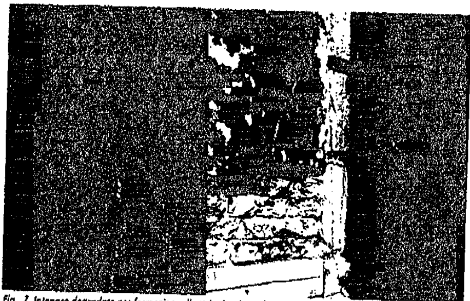
Fig. 7 Intonaco degradato per formazione di ettringite: la malta si rigonfia e si stacca dal muro; i residui di intonaco appaiono tuttavia ancora consistenti.
