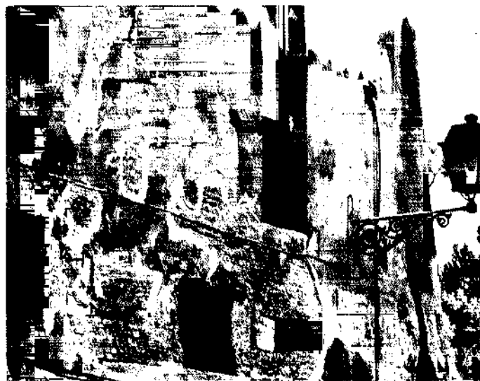
Fig. 7 - Edificio storico a Roma (Portico d'Ottavia): riparazioni ripetute tutte fallimentari di una muratura (sulla sinistra in secondo piano).
