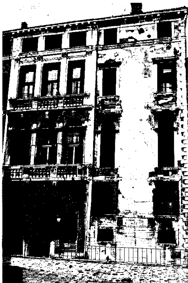
Fig. 4 - Edificio storico a Venezia (Campo Manin): distacco dell'intonaco.
