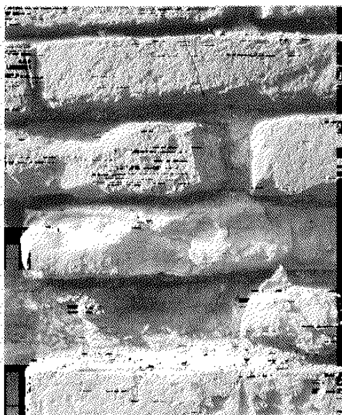
Esempio di mattoni gialli degradati in una zona di mattoni rossi integri
